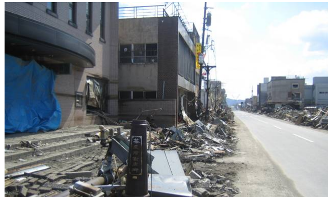
商店街のあった茶屋前通りも壊滅的な被害を受けている。
