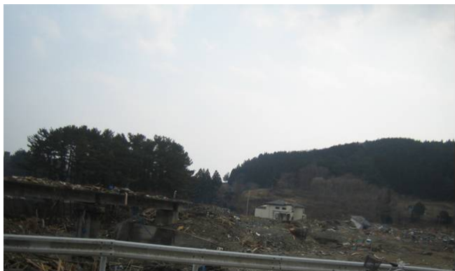
越起喜来の隣の入り江にある泊集落の被害。泊川を遡上した津波によって住家が流されている。
