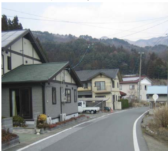
吉浜地区の道路沿いに立ち並ぶ集落の住家 この道路より下には家を建てないようにした。全く津波の被害は受けていない。
