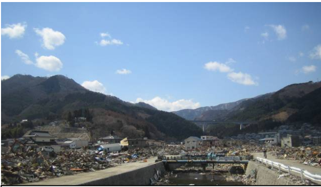
大船渡町のほぼ中心部を流れる須崎川沿いの住宅地は川の遡上と海からの津波で壊滅的な被害を受けている。
