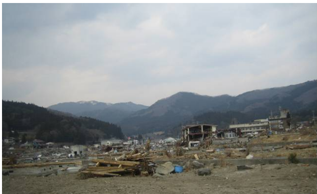
大船渡市三陸町越起喜来地区の中心部の被害。手前側が海になる。奥左上の白い建物が支所
