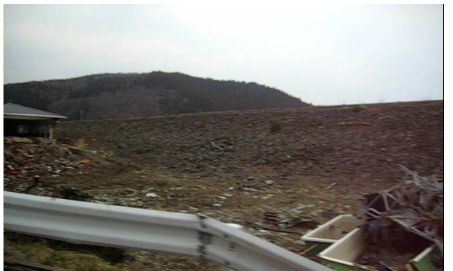
泊の隣の甫嶺集落の被害。後ろの土手は三陸リアス鉄道、その向こうが海である。
