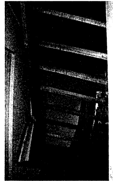
二階天井の野縁が落ち屋根の野地板の裏側が見えている
