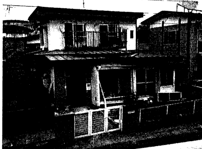
背後にずり落ちている住宅
