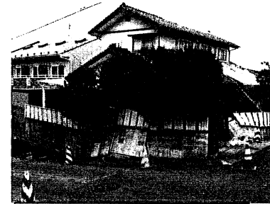
ブロック塀・ブロック擁壁の崩壊
