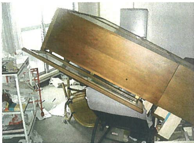
地震後の専有部分室内の状況、家具が倒れている
