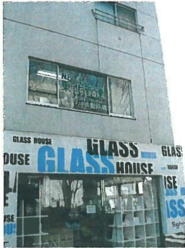
東北管連の事務所がある定禅寺ハイツ、震度6強の揺れだったにもかかわらず、クラック一つ入っていない。
