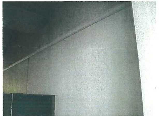
これも耐震補強したマンション、1階ピロティ部分の梁下に 耐力壁を設けて耐震補強したため、まったく被害がない。
