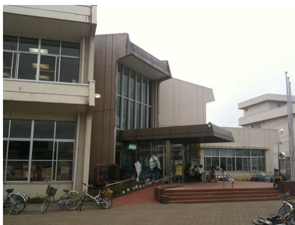
小野市民センター エントランス
