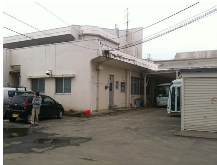
前面、コンテナ吊り下ろし部スペース
