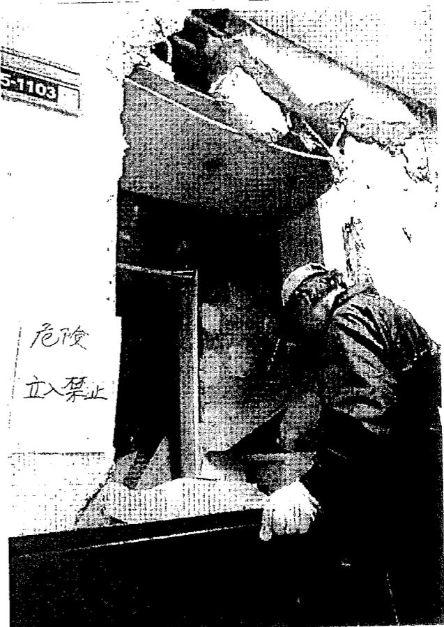
倒れた給水塔の直下にある部屋。悲惨な現状に立ち尽くす所有者の男性 仙台中心部宮城野区で11日
