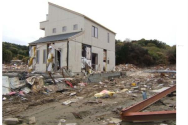
右の写真は今回の被災地で最も印象的な光景である。近接してるから分かり難いがまわりは全て流されて、この一軒だけが津波に耐えてぼつんと残っている。積水ハウスか？一階は津波が通過してめっちゃめちゃだが躯体は歪むことなくしつかり2階を支えている。内外装を直せば十分に使えるのだが解体承諾の紙が貼られていた。もうこの土地に住みたくなかないとの意思表示なのか、コミュニティは再生されるのだろうか。
