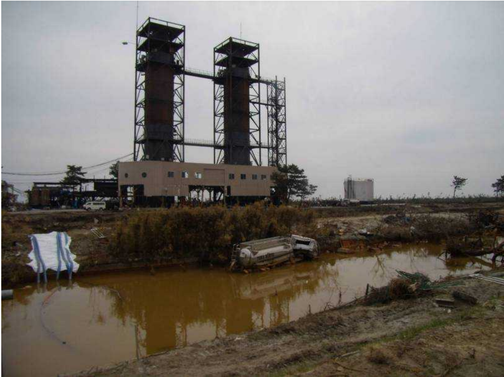
被災した下水処理場
