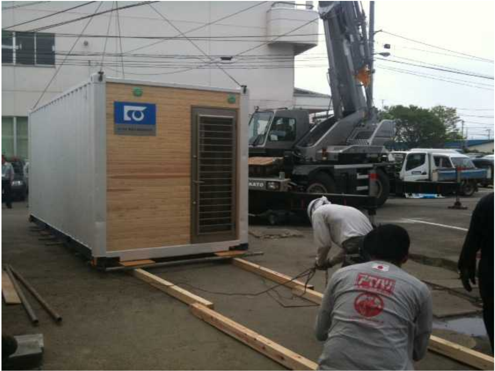
東松島市へのコンテナバスユニット設置 (福岡支部・福永さん、東京支部・丸谷さんらの取り組み)
