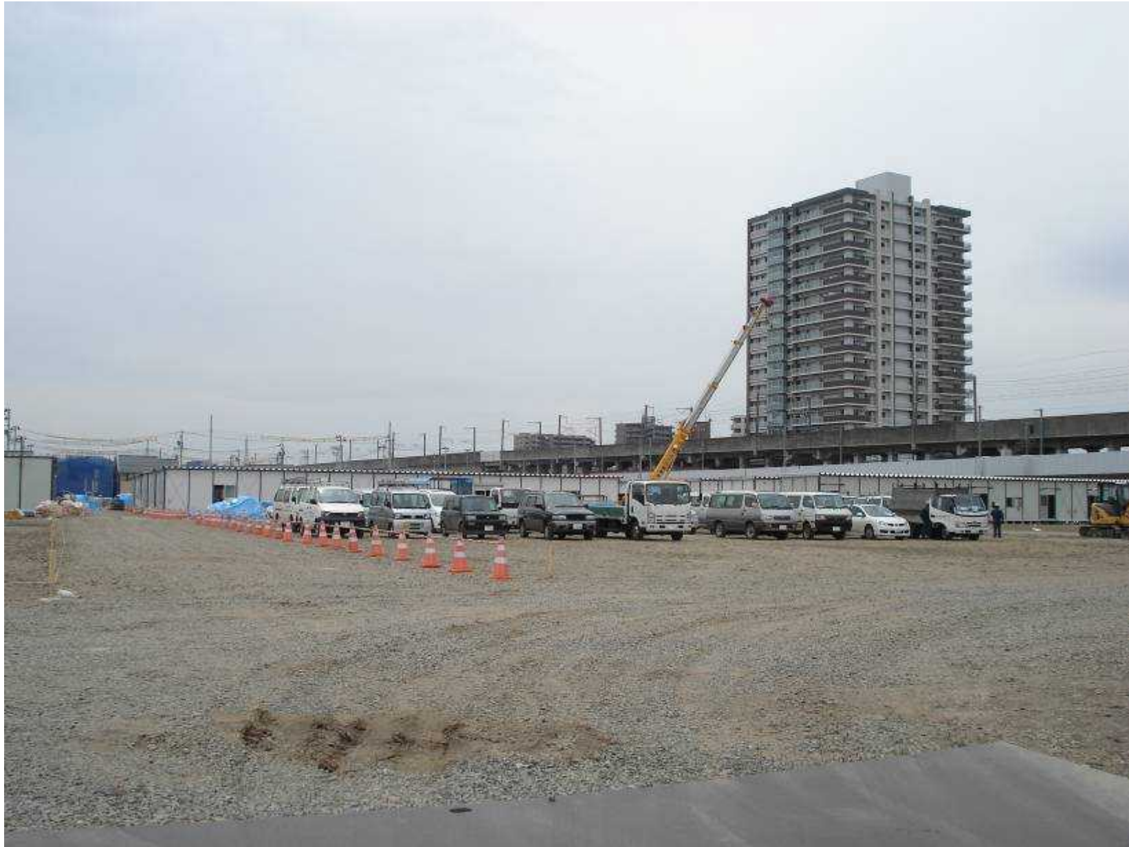
仙台市長町駅操車場跡地における仮設住宅建設(119戸)
