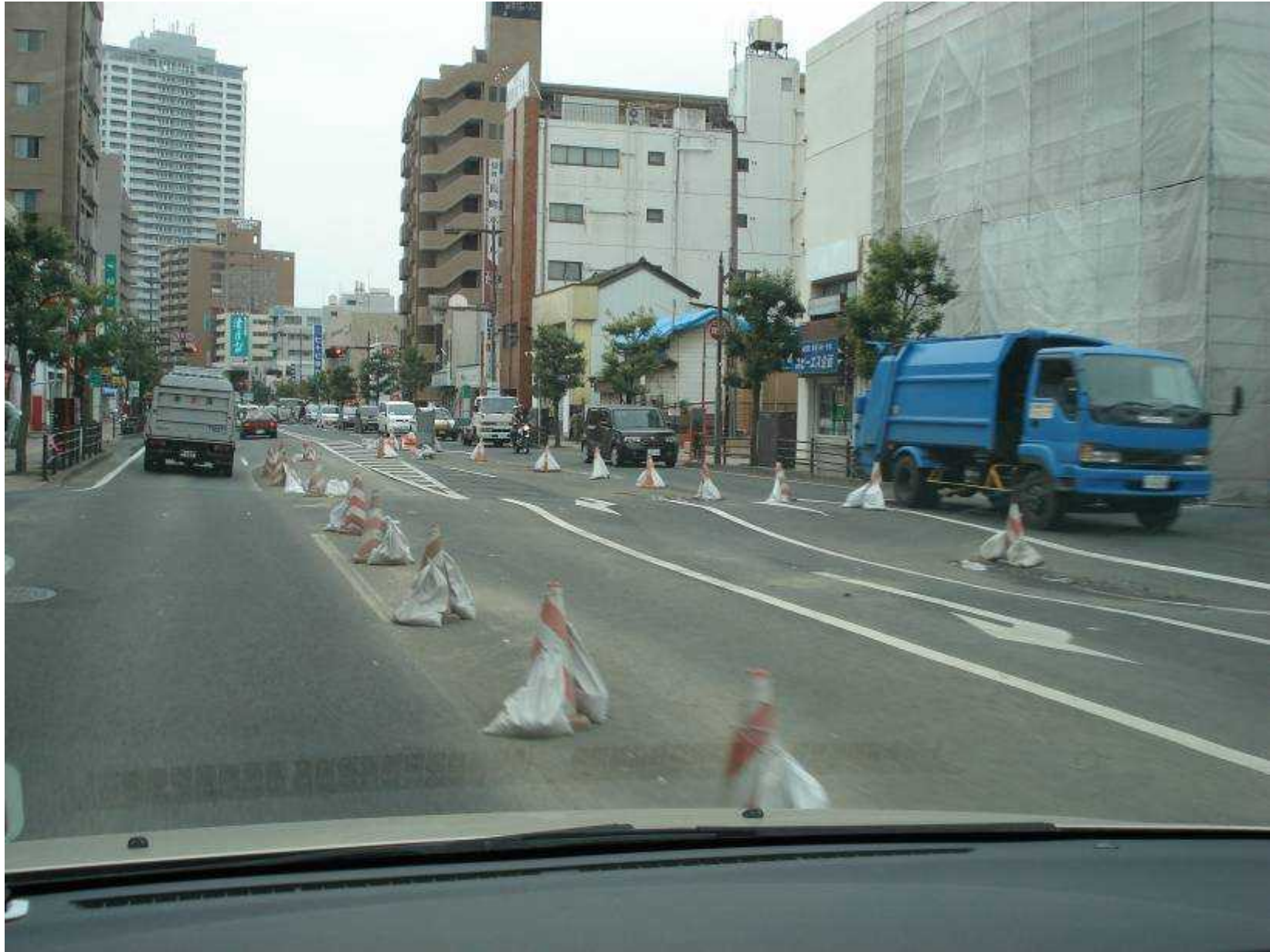
仙台市長町駅周辺(液状化被害)
