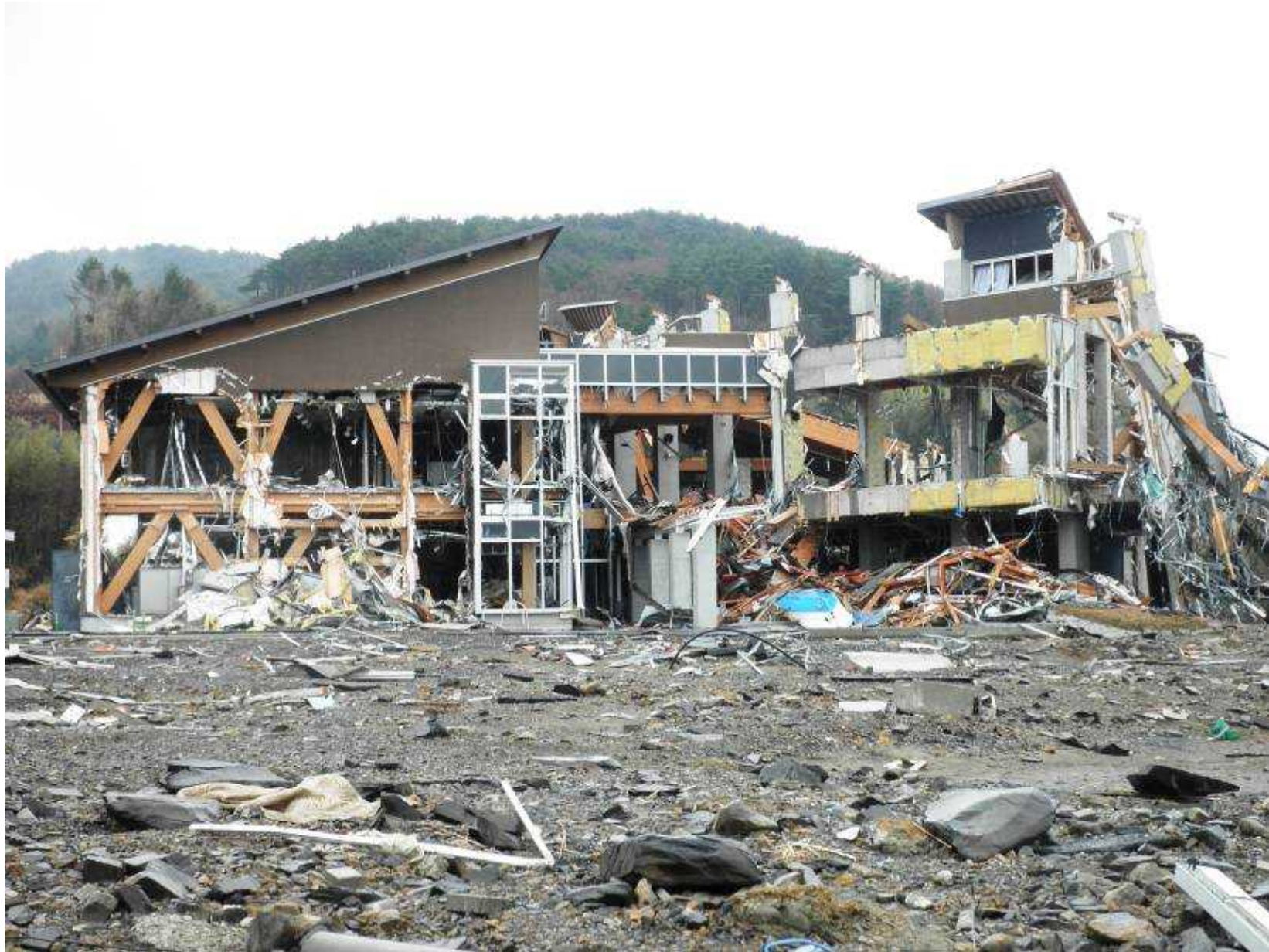
石巻市北上総合支所(18名が亡くなった)
