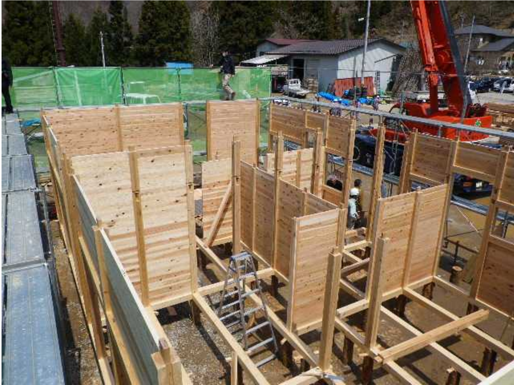
福島県いわき市での木造仮設住宅の建設 (新建でも講演いただいた筑波大学安藤邦廣先生らの取り組み)
