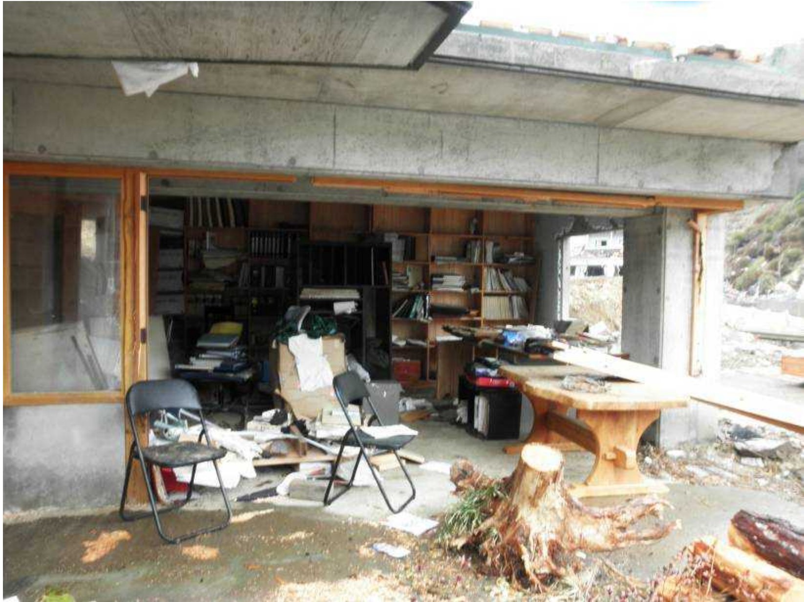
事務所部分の様子
