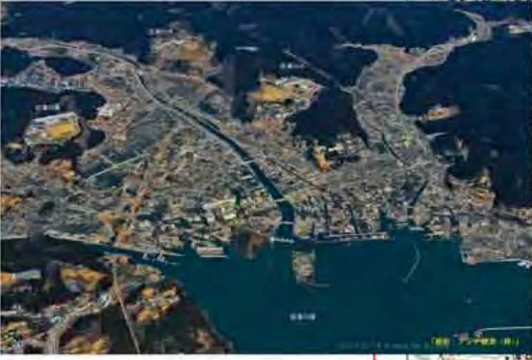
南三陸町 志津川周辺の被災状況
