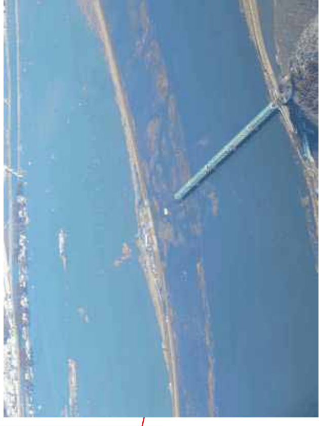
国道398号新北上大橋
